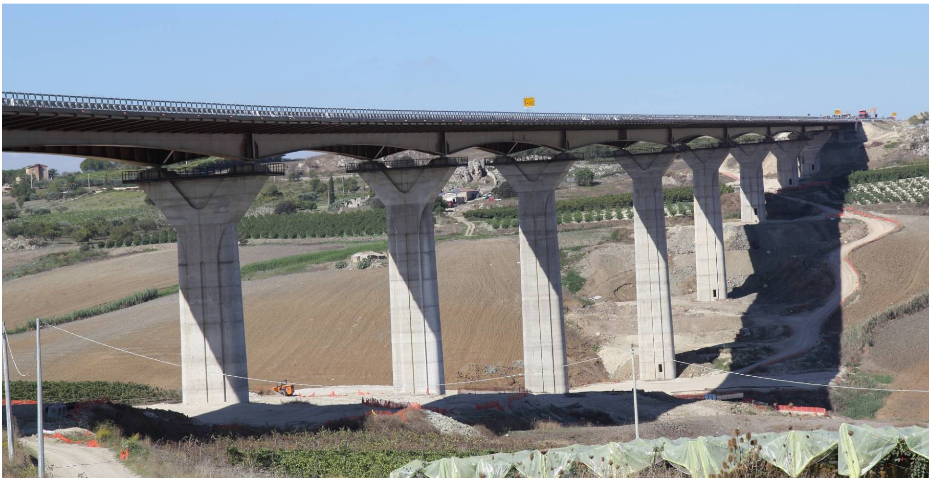
Fig. 11: Campata da 90 m e vista laterale
