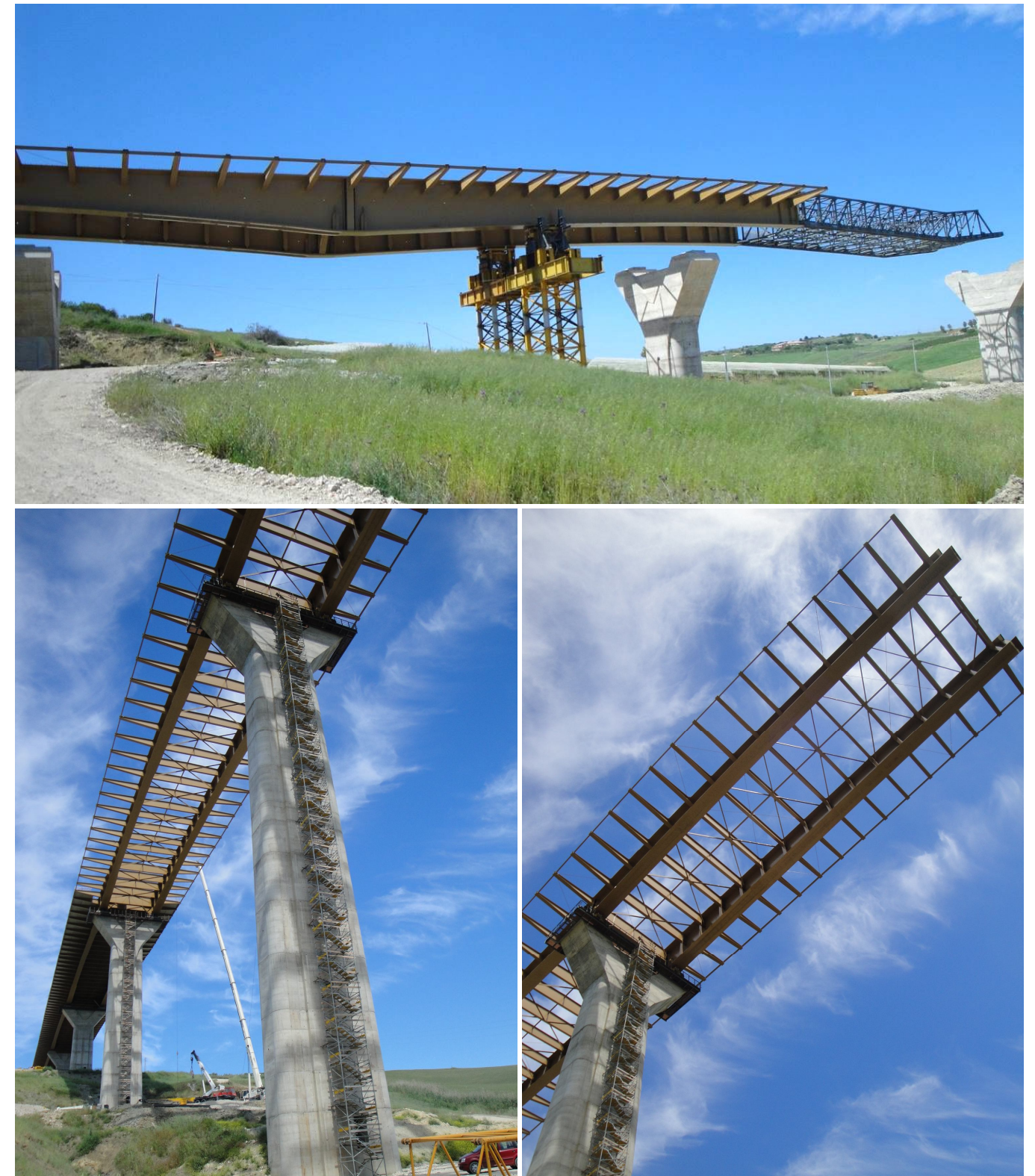
Fig. 7: Varo carpenteria metallica
