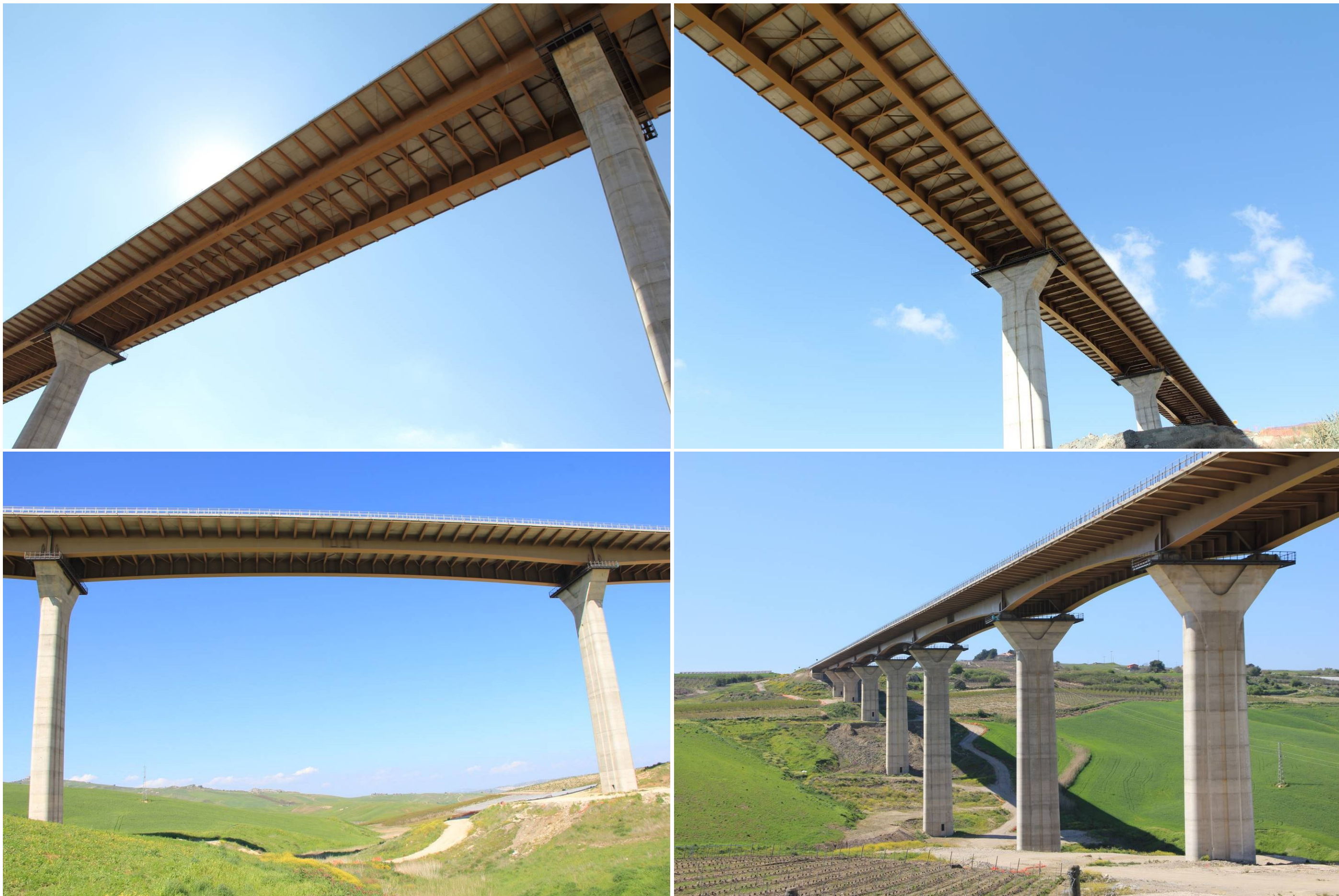
Fig. 10: Viste del viadotto finito
