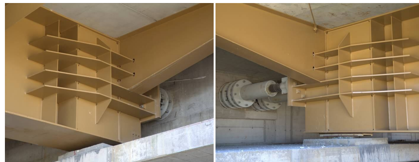
Fig. 5: Dispositivi di ritegno elastico da 4000 KN e dispositivi da 4000 KN accoppiati a shock transmitter
