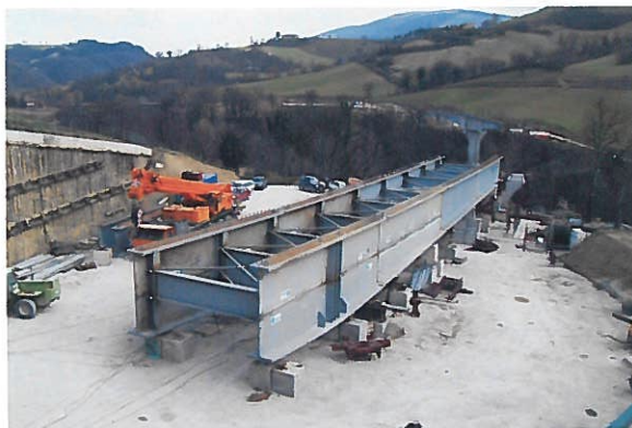
Photo 4 : Lancement de la 2 e moitié du tablier / Launching of the second half bridge
