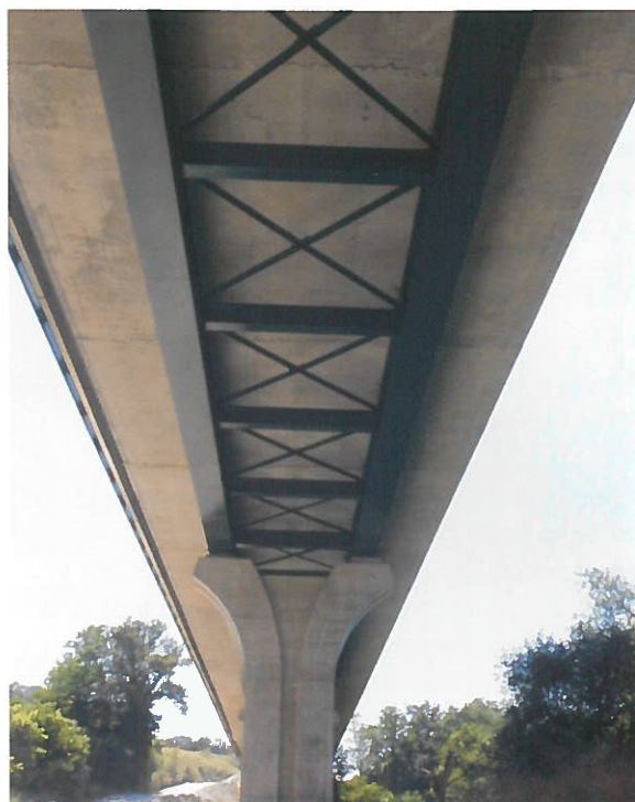
Photos 24 : Viaduc Ca' Raniero 2 / Viaduct Ca' Raniero 2
