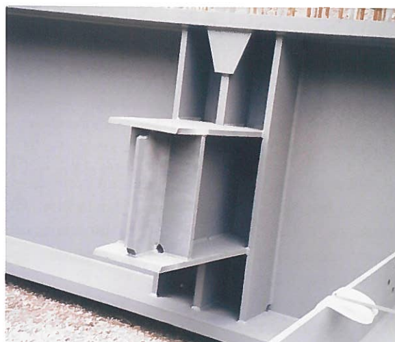
Photos 17b : Montant sur appuis / Support stiffener
