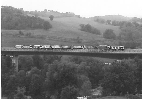
Photo 16 : Épreuve de chargement travée centrale / Test loading of central span
