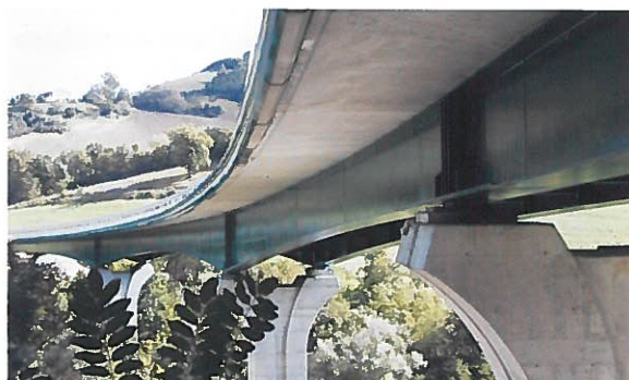
Photo 14 : Vue latérale du viaduc / Lateral view of the viaduct
