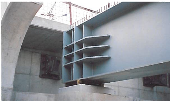
Photo 19 : Culée fixe / Fixed abutment
