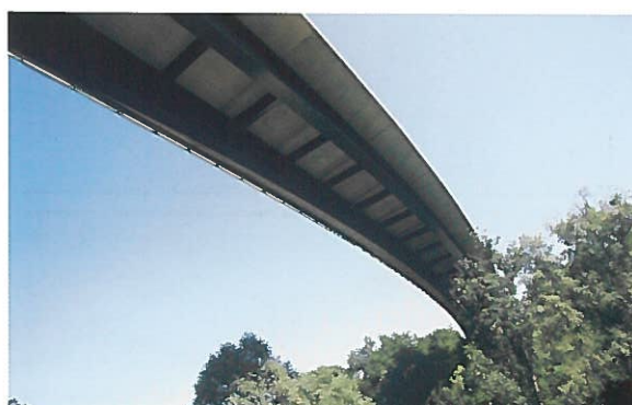
Photo 15 : Vue du dessous / View from below
