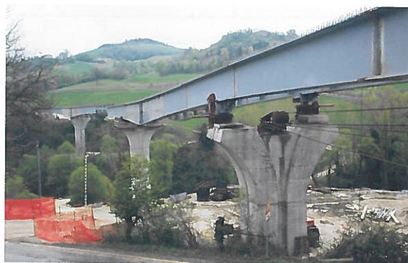
Photo 9 : Phases finales du lançage / Final launching phases
