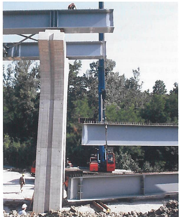
Photos 21 : Mise en place à la grue / Mounting by cranes
