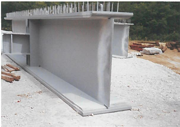
Photo 18 : Tronçon avec semelles additionnelles / Flanges with superimposed plates
