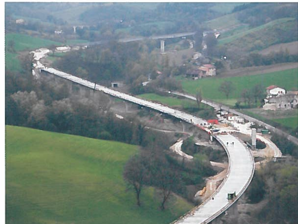
Photo 1 : Le chantier de la bretelle d'Urbino avec au premier plan le viaduc Ca' Raniero 1 / The site works of Urbino bypass with the Ca' Raniero 1 in front
