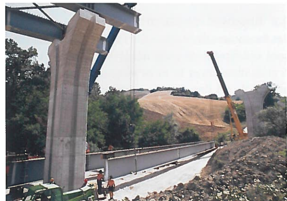
Photos 22 : Mise en place à la grue / Mounting by cranes
