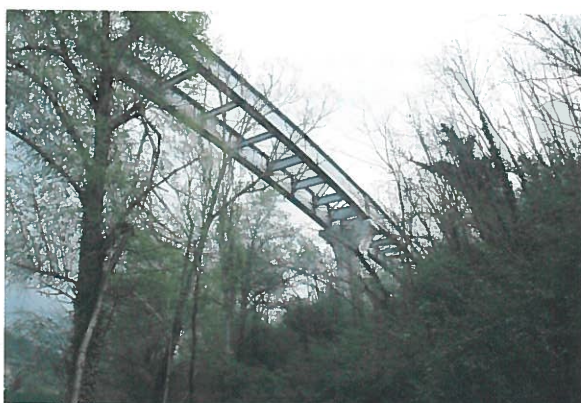
Photo 7 : 1 ère moitié du tablier / First half bridge
