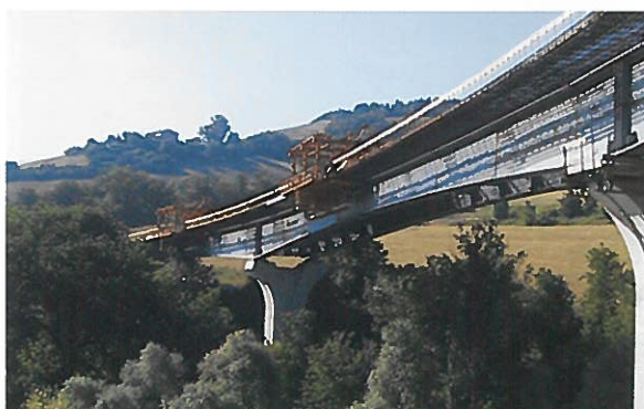
Photo 12 : Tablier en cours de bétonnage / Concreting of deck
