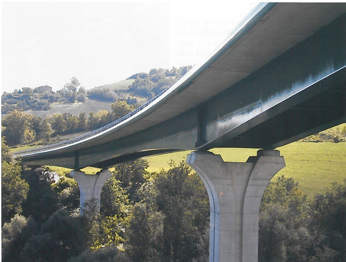
Photo 1 : Vue d'ensemble d'un viaduc de la bretelle / Global view of one viaduct of the bypass
