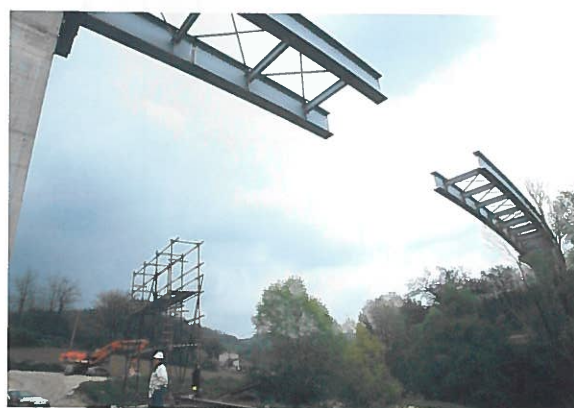
Photo 10 : Phases finales du lançage / Final launching phases
