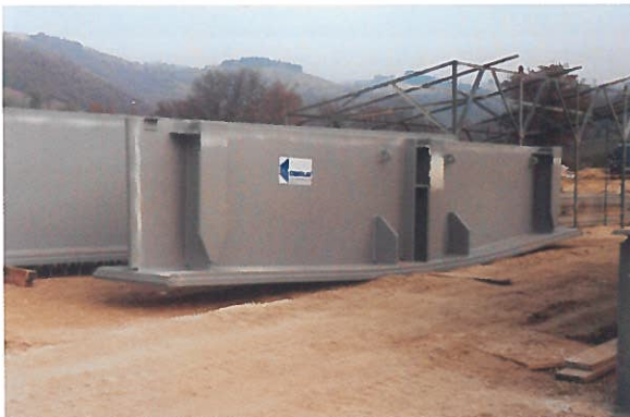
Photo 3 : Tronçons sur piles P2 et P3 / Segment over piers P2 and P3
