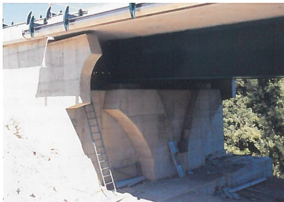
Photo 20 : Culée mobile / Mobile abutment
