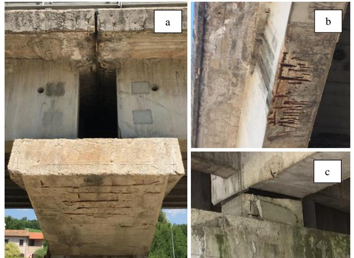
Figure 10. Degradation of a) joints and pier caps, b) beams and slab and c) supports / Stato di degrado di a) giunti e pulvini, b) travi e soletta e c) baggioli.
