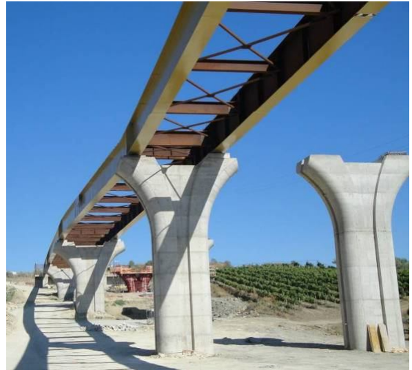
Figura 4 – Campata con allargamento impalcato
