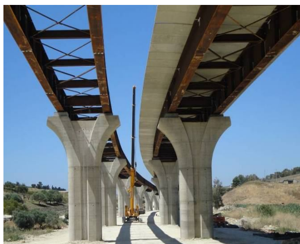
Figura 2 - Vista centrale dei due viadotti affiancati
