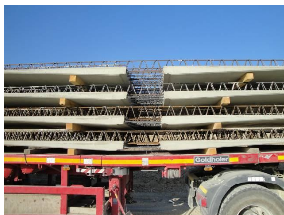
Figura 9 - Costruzione e trasporto predalle a spessore variabile
