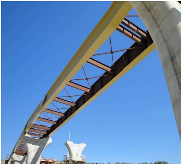
Figura 4 – Campata con allargamento impalcato
