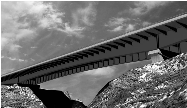
Fig. 1: Campata centrale del viadotto Venturello (rendering)
